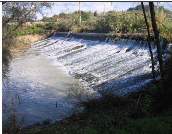
Foto n.5, 09/11/2011 Pescaia di San Galgano, non sono visibili schiume
