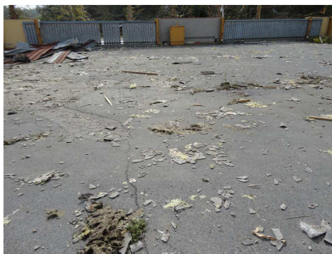
Figura 1 – Immagine di un'area invasa dai frammenti di MCA subito dopo l'evento
