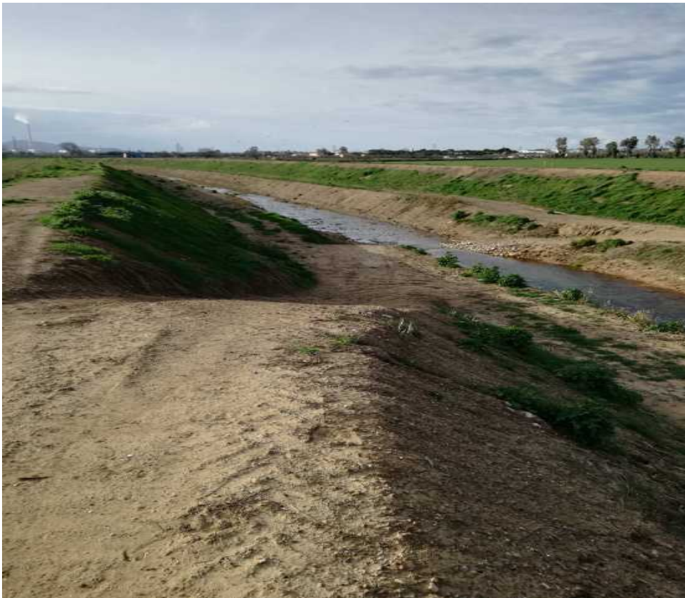
Illustrazione 3: Torrente Pecora - lavori consolidamento sponde
