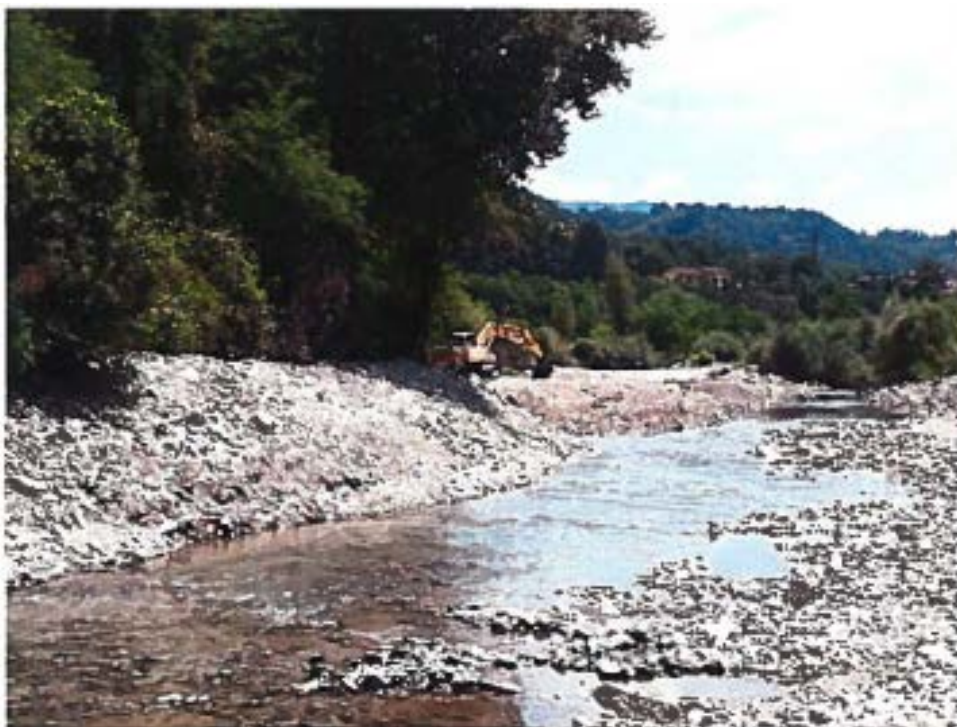
Illustrazione 4: Torrente Turrite di Galliciano - interventi in alveo
