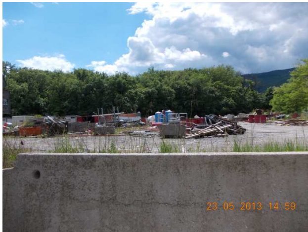
Foto.9) del 23/05/2013: vi si nota sulla sinistra un cumulo di rifiuti da demolizione
