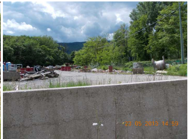
Foto 12) del 23/05/2013: vi si notano legnami da armature pedane in legno rotte e rottami ferrosi dispersi nell'area
