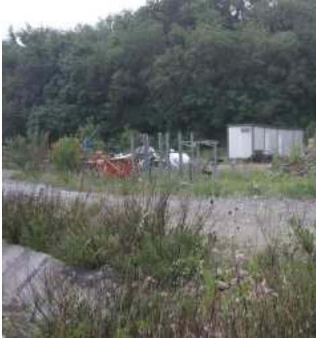
Foto 17) del 23/05/2014 qui si vedono le stesse baracche di cantiere di cui alla foto 10 del 23/05/2013 e parte del cumulo dei rifiuti di demolizione
