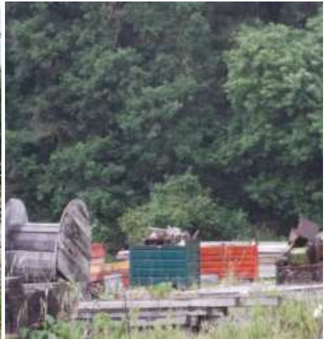
Foto 22) del 23/05/2014 attrezzature da cantiere
