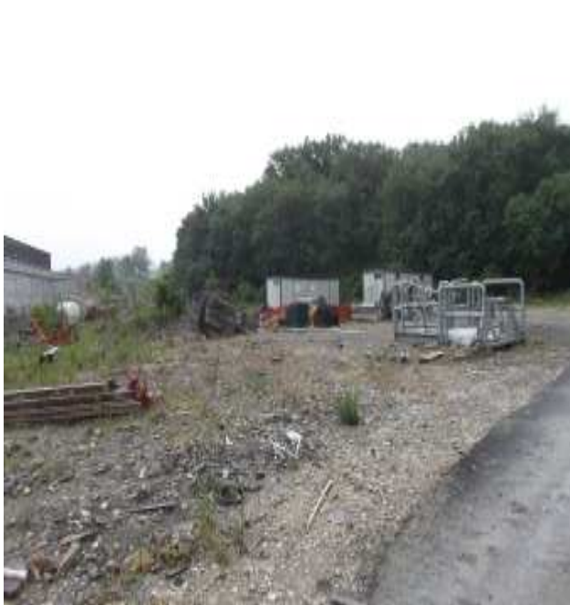
Foto 13) del 23/05/2014: a sinistra della foto vi si nota lo stesso cumulo dei rifiuti di demolizione di cui alle foto 9 e 10
