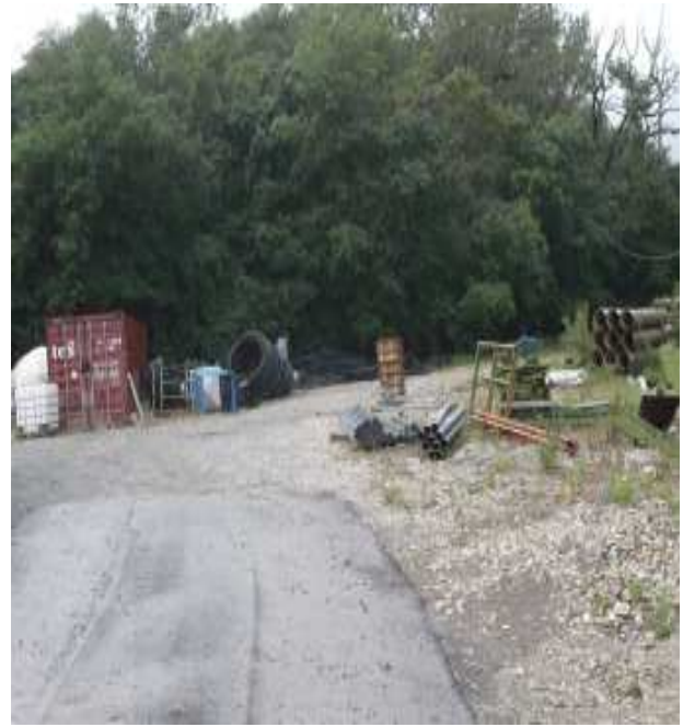
Foto 14) del 23/05/2014 : qui vi si notano attrezzature e materiali di cantiere con lo stesso container di cui alla foto 10
