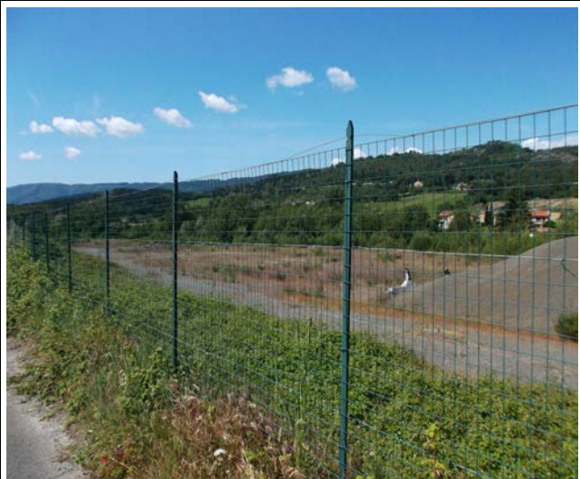
Foto n.6 panoramica lato sud
