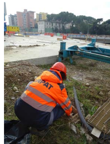
Misura su piezometro, cantiere Stazione AV.
