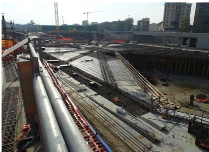
Cantiere Stazione AV - novembre 2017.
