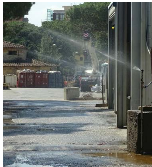
Bagnature dell'impianto di betonaggio, cantiere Stazione AV.
