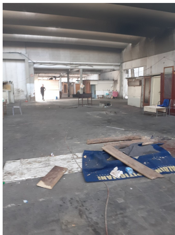
Foto 2: baracche all'interno del capannone
