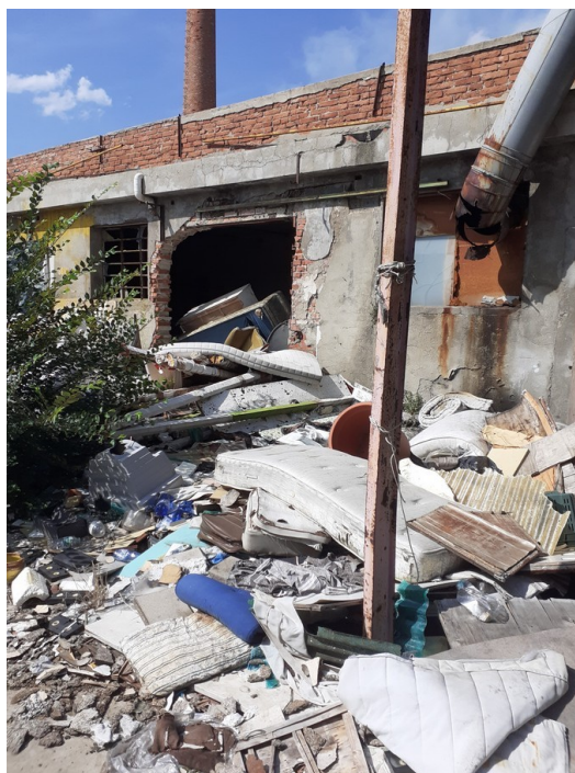
Foto 15: cumuli rifiuti piazzale esterno retro-lato edificio
