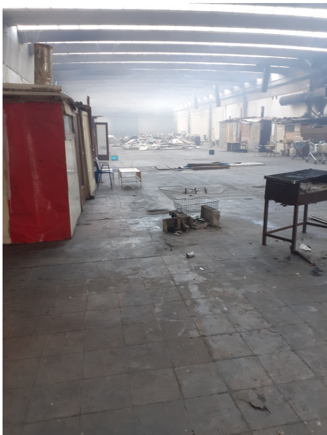
Foto 1: baracche all'interno del capannone
