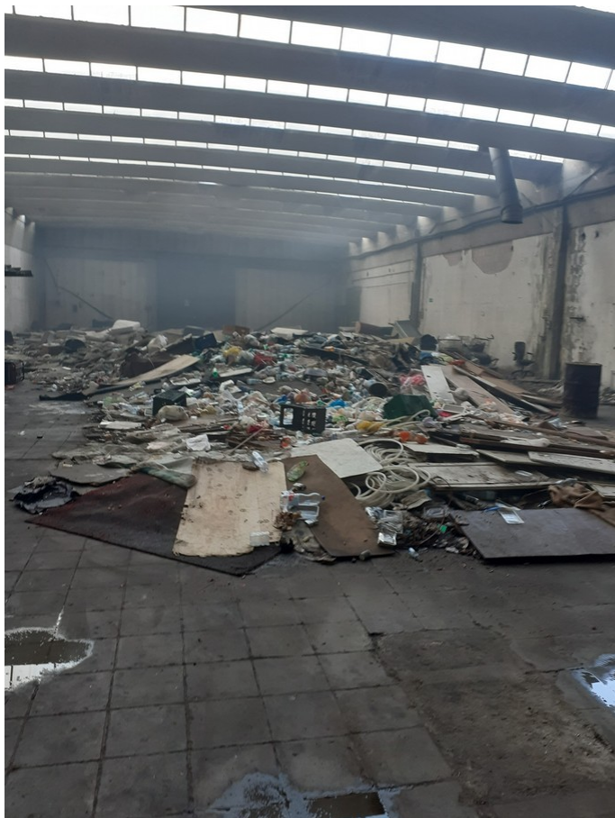
Foto 11: cumuli di rifiuti all'interno del capannone
