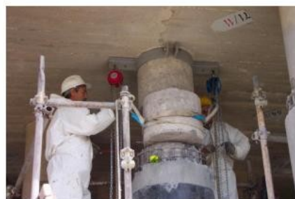
Asportazione dei conci dei pilastri
