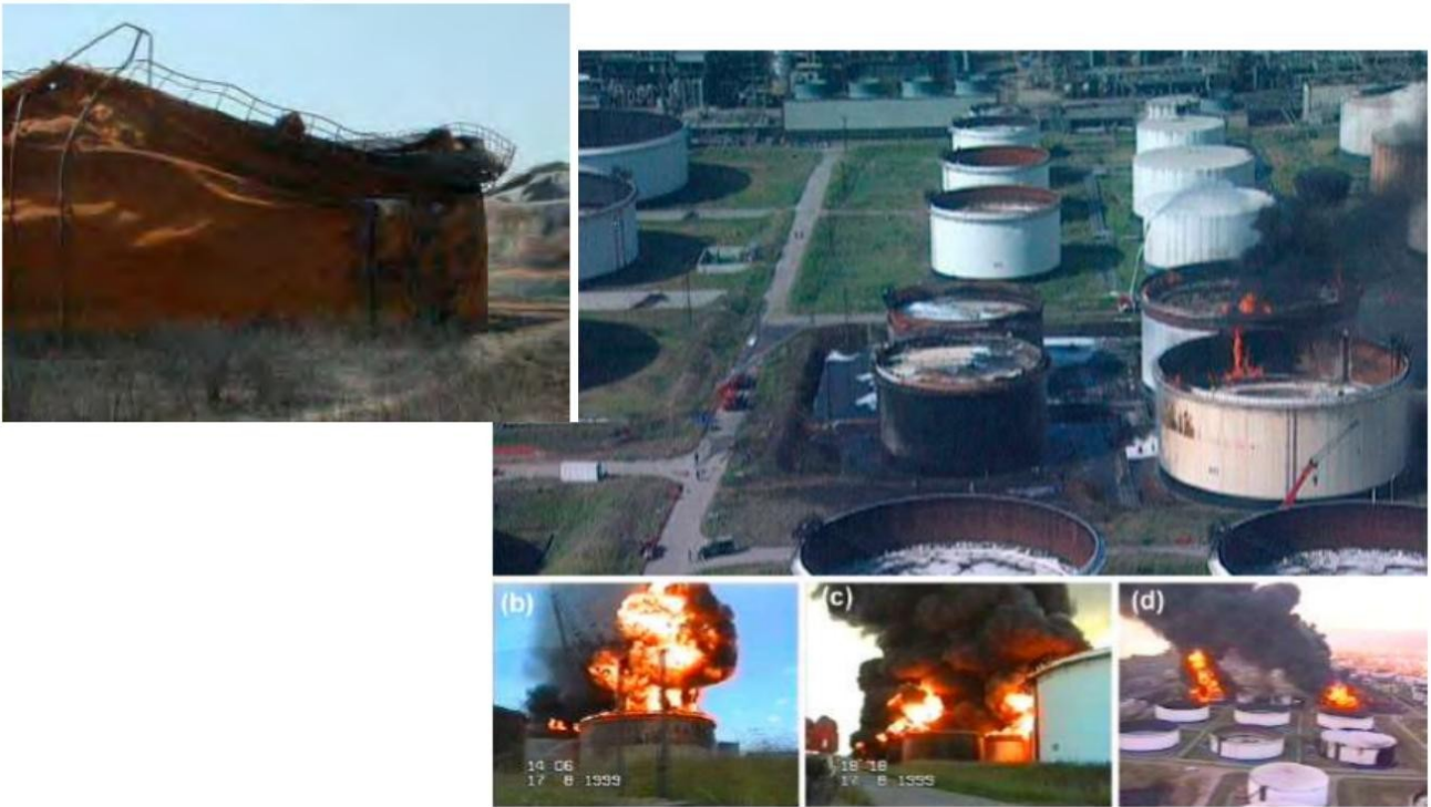
Terremoto di Kocaeli (Turchia) del 1999; M = 7.4 - raffinerie Yarimca e Tupras
