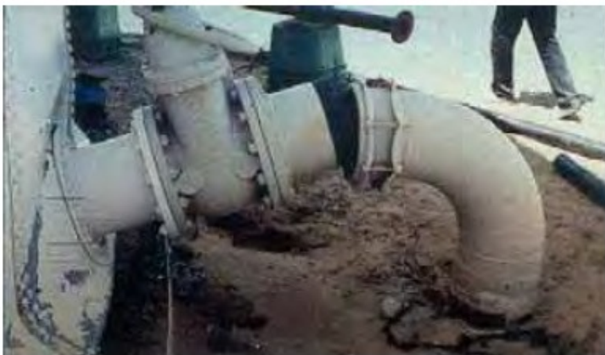
Figura 4 – Rottura tubazione
