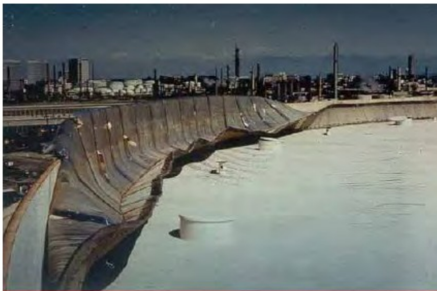
Danni alla copertura di un serbatoio nel terremoto di Landers - California del 28.06.1992
