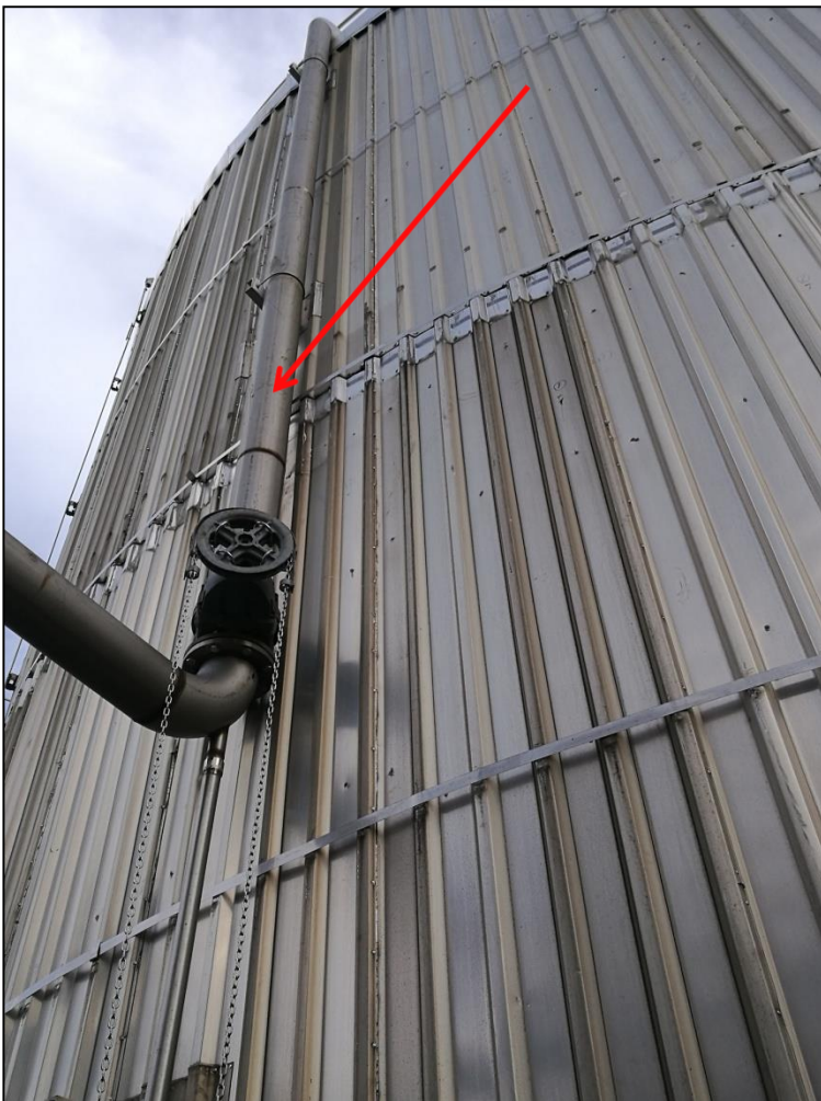
Particolare della calata da un singolo serbatoio
