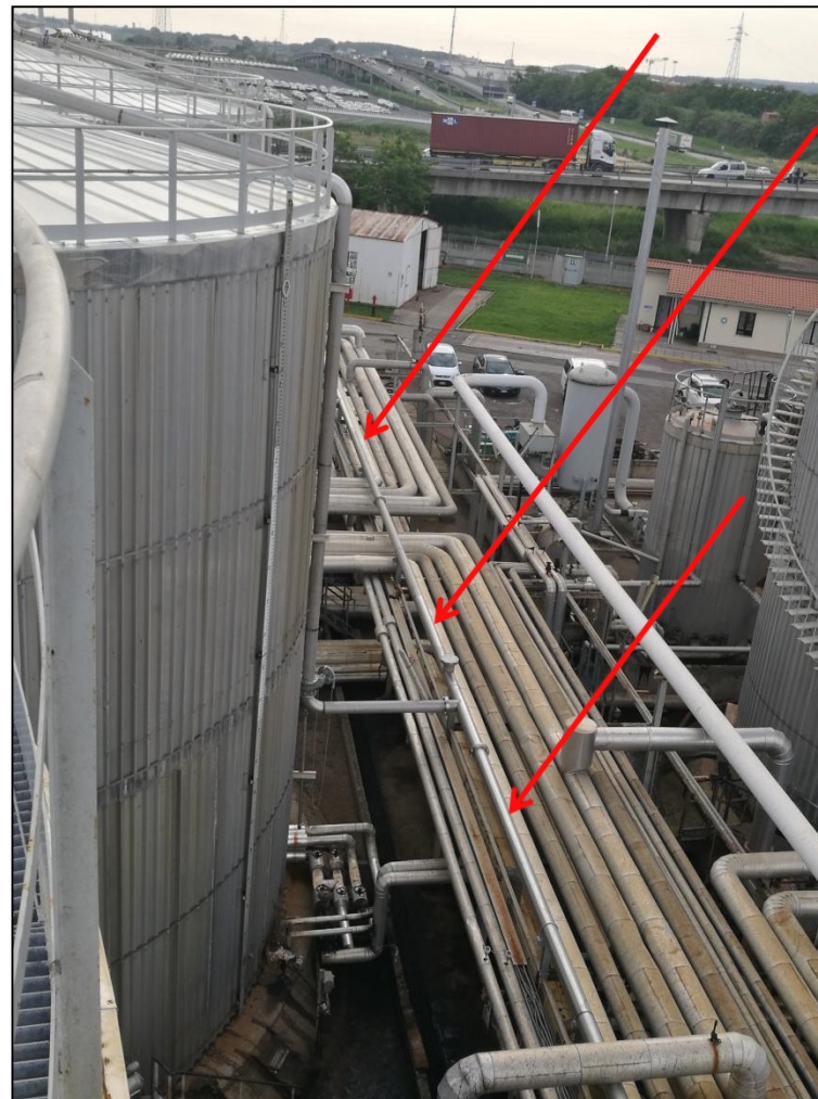
Particolare della tubazione principale di collettamento dei vari serbatoi
