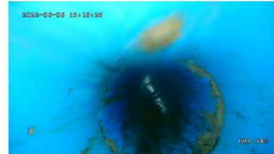
Foto 13: Fotogramma da videoispezione dalla tubazione di rivestimento del T2 alla profondità di circa 3,5 m dal pc.
