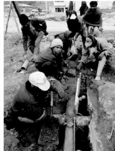
Posa di condotte per l'acqua e per le fognature, una misura che facilita la disponibilità di acqua potabile e migliora il livello igienico.
