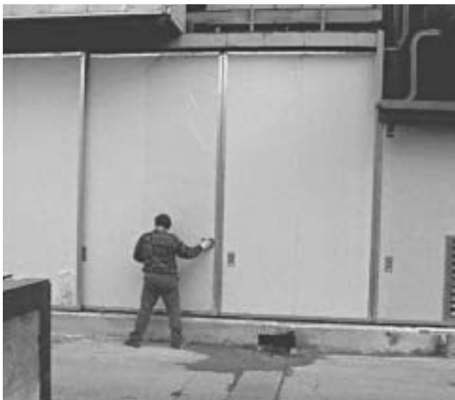
Fig. 3.9.27 Portoni scorrevoli realizzati in materiale fonoassorbente
