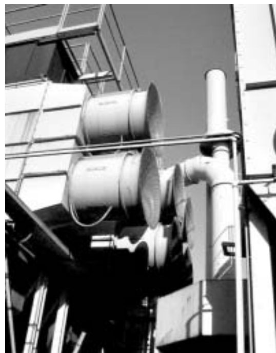
Fig. 3.9.26 Particolare dei ventilatori per il raffreddamento dei fumi delle emissioni dai forni fusori a cubilotto, prima di essere immessi nei filtri a maniche
