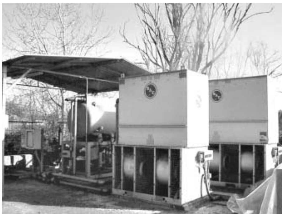
Fig. 3.9.12 Impianto di addolcimento e raffreddamento dell'acqua utilizzata per il raffreddamento dei forni
