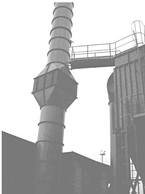
Fig. 3.16.1 Camino dotato di silenziatore.
