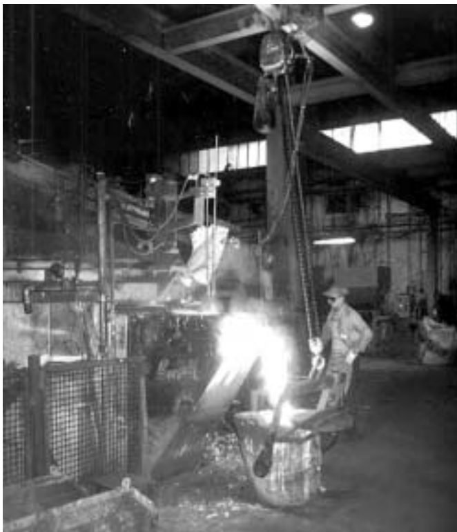
Fig. 3.10.1 A/B: spillatura del metallo fuso dal forno. A: in siviera di piccole dimensioni. B: in siviera di grandi dimensioni
