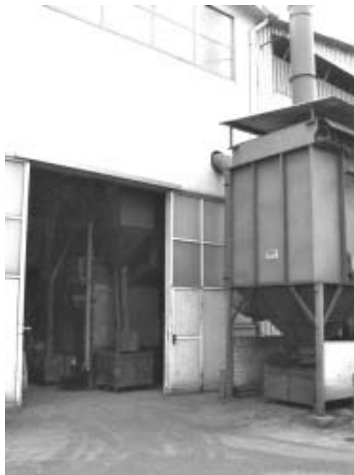
Fig. 3.13.5 Impianto abbattimento a secco (filtro a maniche) delle emissioni in atmosfera di polveri aspirate alla granigliatrice
