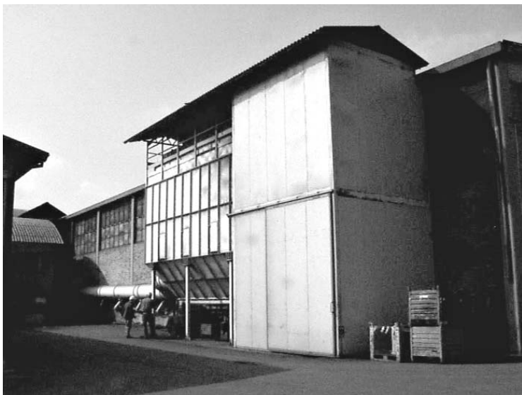
Fig. 3.14.9 Impianto insonorizzato di abbattimento delle emissioni provenienti dalla aspirazione localizzata alle cabine di sbavatura
