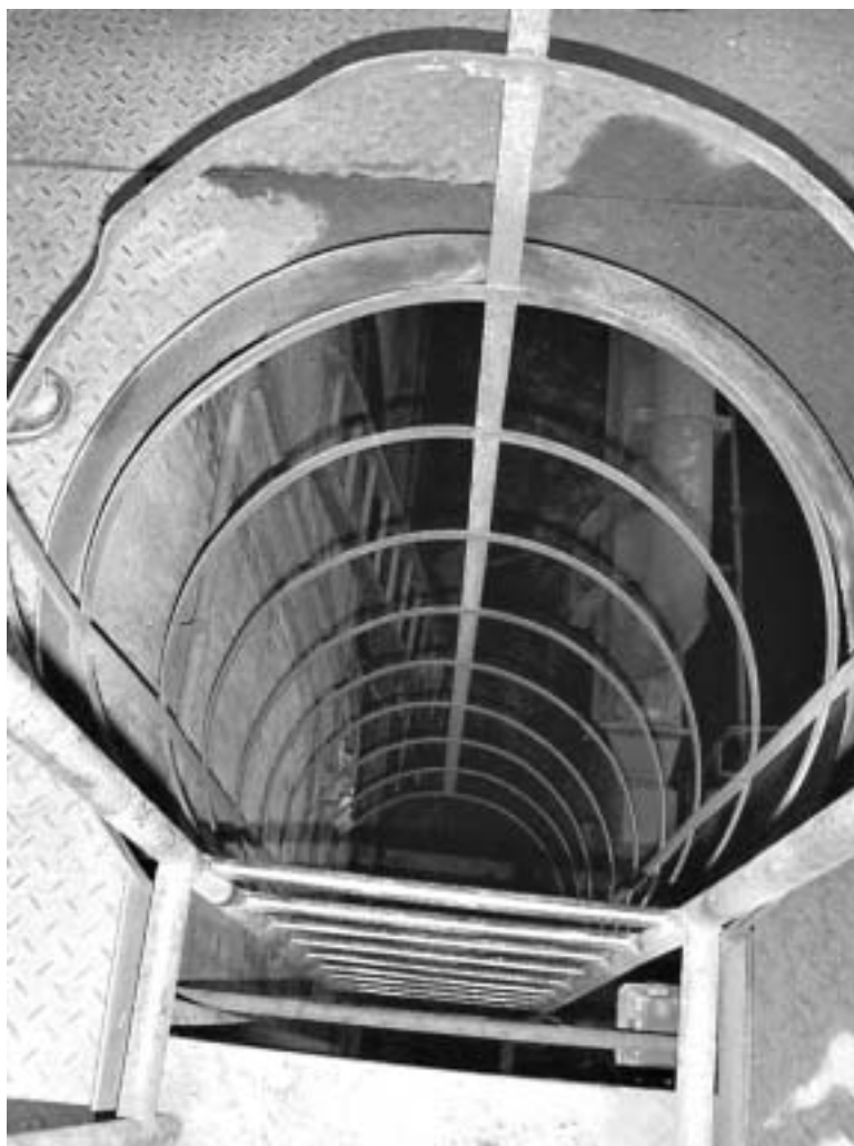
Fig. 3.2.10 Accesso ai cunicoli sotterranei tramite scala verticale fissa dotata di gabbia di protezione, la cui botola è protetta da parapetto e fascia fermapiedi
