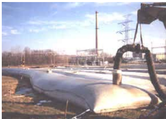
Figura 45. – Tubi in geotessile filtranti. L'acqua che trasuda non contiene contaminanti poco solubili in acqua.
