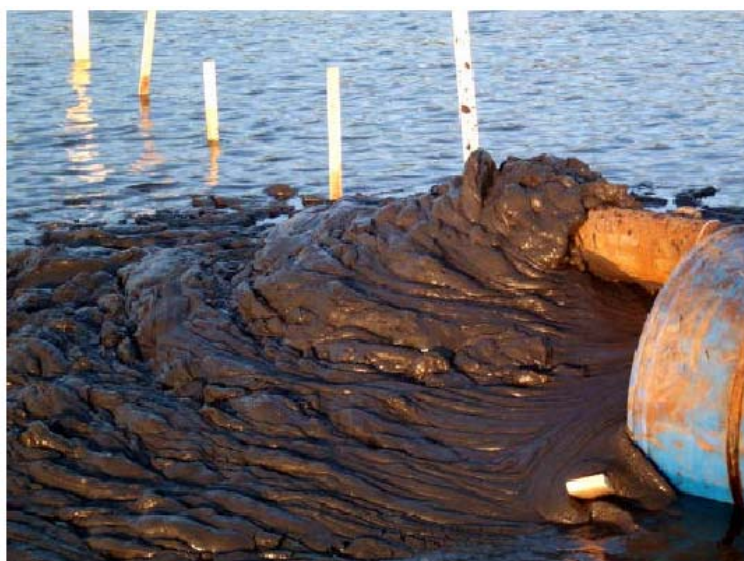
Figura 44. – Sedimenti rimossi con dry-dredging .
