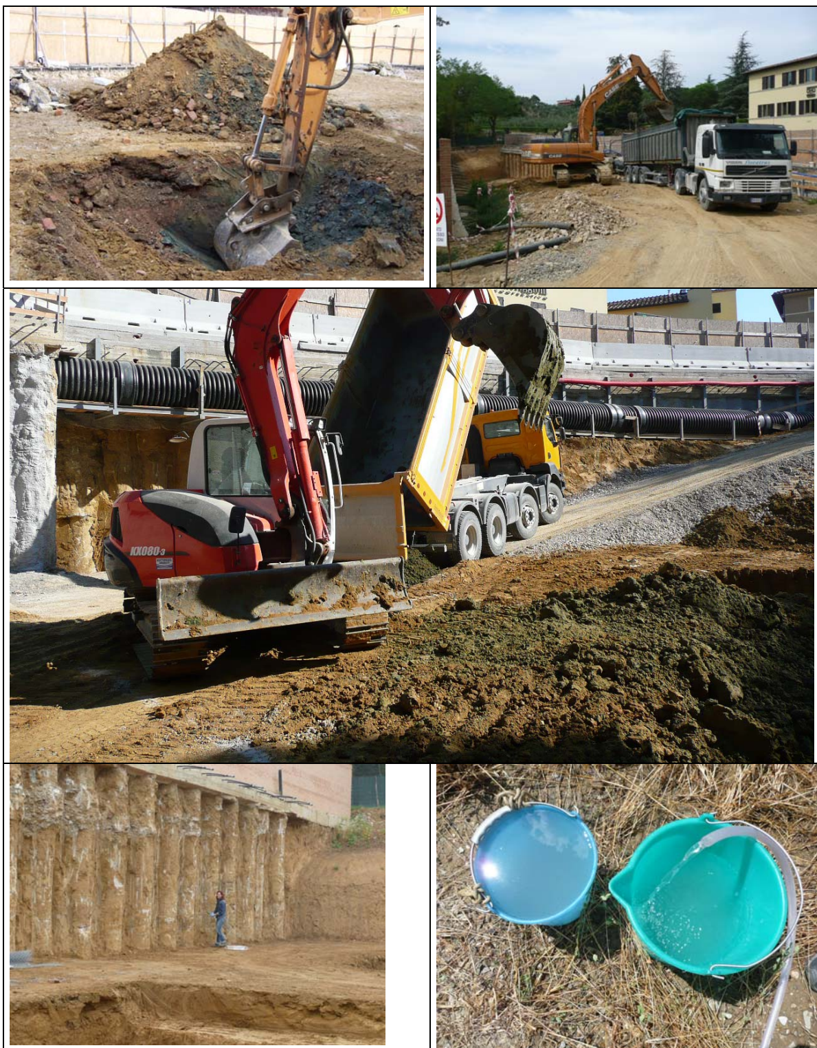
Figura 4. – Rimozione di un terreno contaminato da idrocarburi alifatici ed aromatici, leggeri e pesanti.
