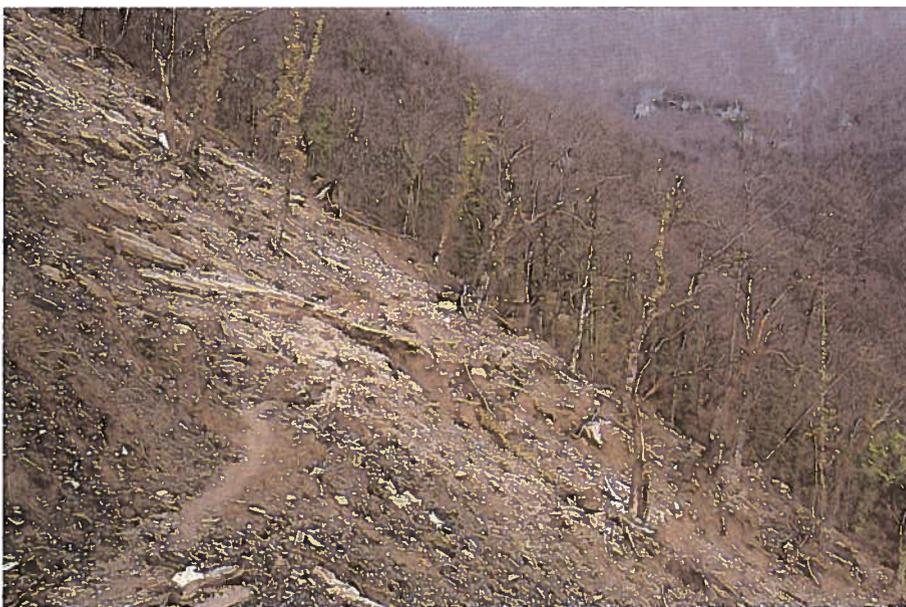
Figura A2 Corpo centrale della frana. Ancora evidente la quantità di rocce scoperte su cui saranno realizzati gli interventi di ingegneria naturalistica fra cui l'inerbimento potenziato con "bianco-verde".
