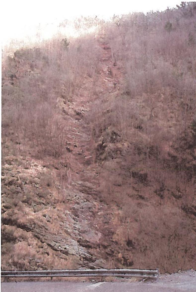
Figura 5.3.4 Erosione lineare
