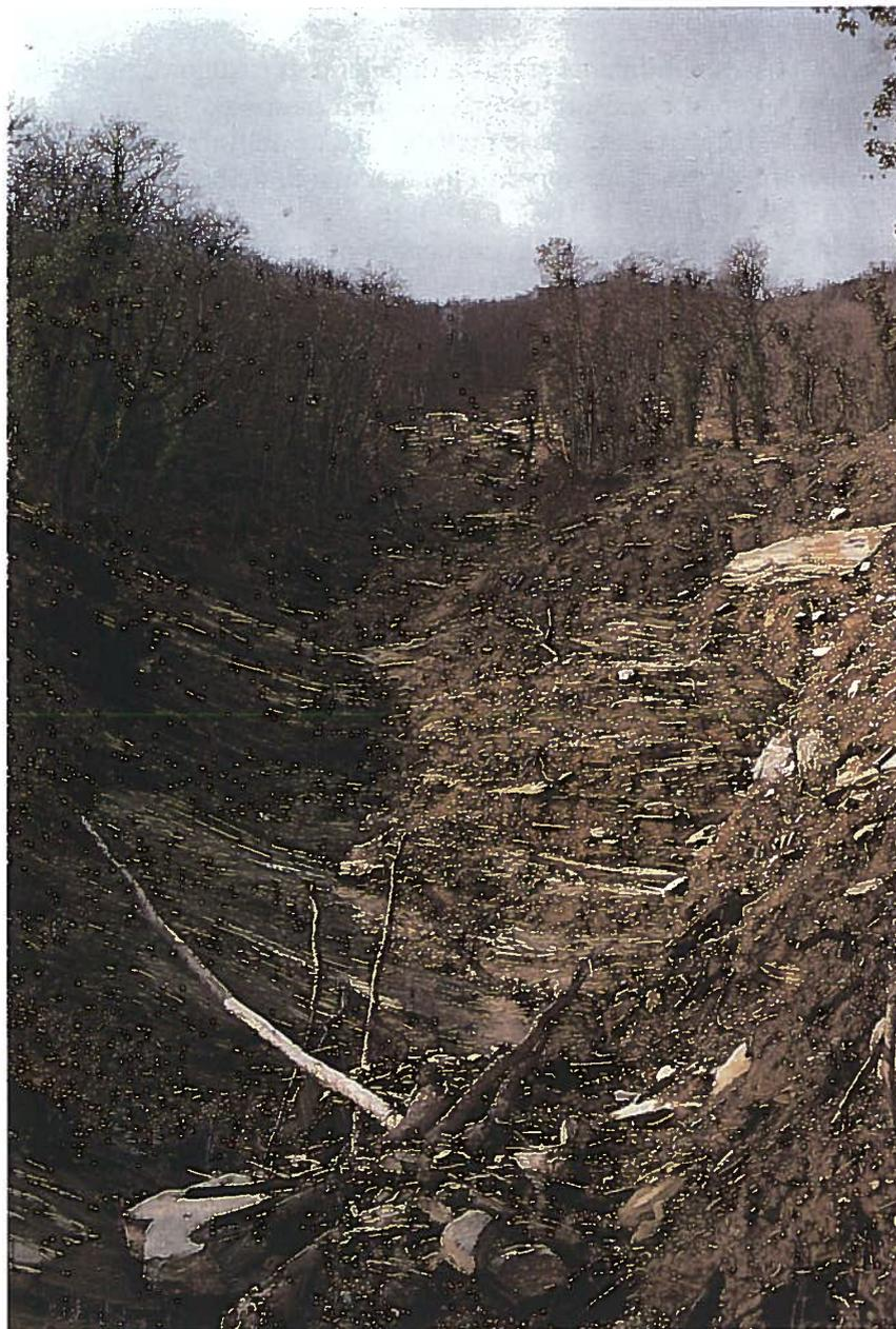
Figura A5 Vista panoramica verso monte del braccio sinistro, stretto e lungo, della frana C1. Qui si nota bene la sequenza delle opere a verde per il recupero naturalistico: briglie al centro dell'impluvio e copertura diffusa con astoni per sostenere le sponde dello stesso. Le operazioni saranno precedute dal disaggio della vegetazione instabile e delle rocce pericolanti, nonché della rilocalizzazione dei detriti stessi.
