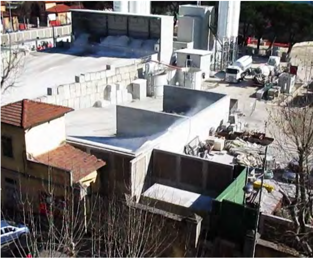
evidenze di risollevamento polveri da cumuli di materie prime a causa del vento (mattina del 12/3/15)
